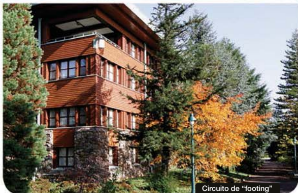
Circuito de "footing"
